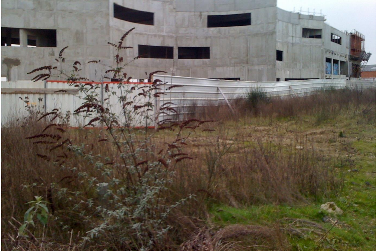
Délaissé en cours de réaffectation, La Riche, M.Brun ©, 2014
